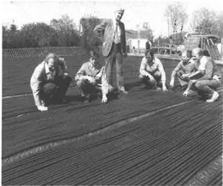
Kommunale Initiative in Helmstedt: Ein Solar-schwimmbad wird gebaut. 26 Kilometer schwarzer Kunststoffrippenrohre sind auf einer schwarzen Folie plaziert. 1400 Stecker verbinden die Rohre. Die Sonne heizt das durch die Rohre fließende Wasser auf, welches dann in die Beckenanlage geleitet wird.
